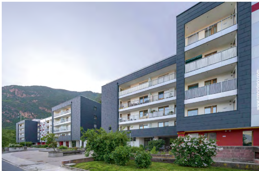
Wohnanlage Sinfonia in Bozen: energetische Sanierung mit Sonnenkollektoren und Wärmepumpen in bewohntem Zustand. Architektur: ARCH+MORE ZT GmbH
