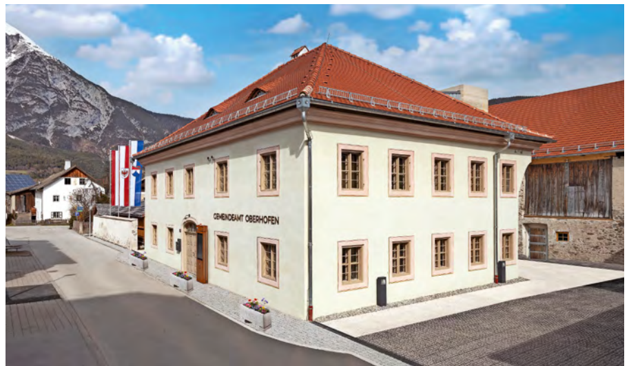
Die Revitalisierung des Rimml-Areals in Oberhofen, Tirol, ist ein Projekt zur Dorferneuerung aus der Periode 14-20, dem ein Ortsentwicklungsprozess voranging. Das denkmalgeschützte alte Gasthaus wurde in ein Gemeindeamt umgebaut, der Wirtschaftshof zum Kulturstadl. Architektur: Buchauer und Kröpfl
