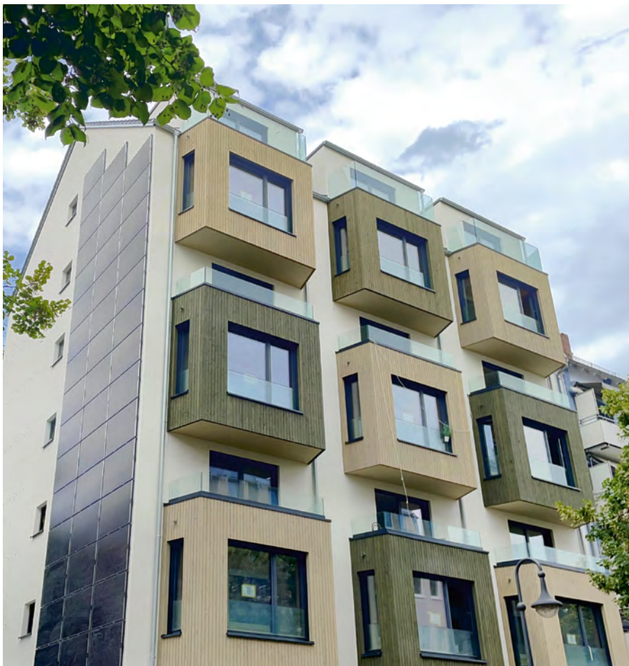
Serielle, energetische Sanierung in Frankfurt/Main: 7-geschoßiger Wohnbau in bewohntem Zustand mit Zellulose-Dämmung. Architektur: raum für architektur, kay künzel + partner
